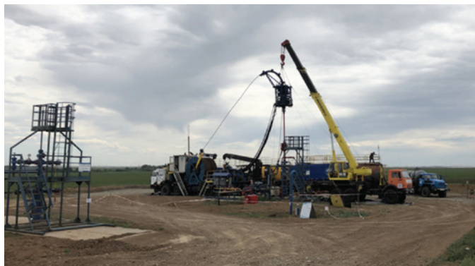
Рисунок 2: Производство работ по КСТ на скважине G
